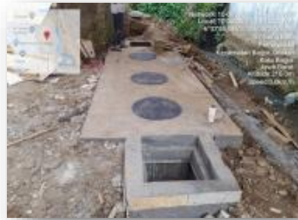
Gambar 1.6 Pembangunan/Penyediaan Sistem Pengelolaan Air Limbah Domestik Setempat di Kelurahan Pamoyanan Kecamatan Bogor Selatan
