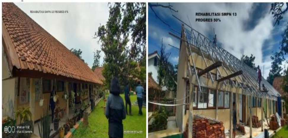
Gambar 2.3.27 Kegiatan Rehabilitasi Sekolah dan Penambahan Ruang Kelas Baru
