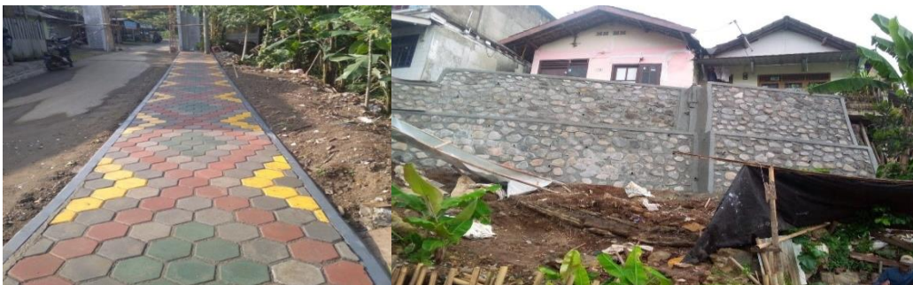
Gambar 2.3.15 Kegiatan Perbaikan Jalan Lingkungan dan Perbaikan Drainase
