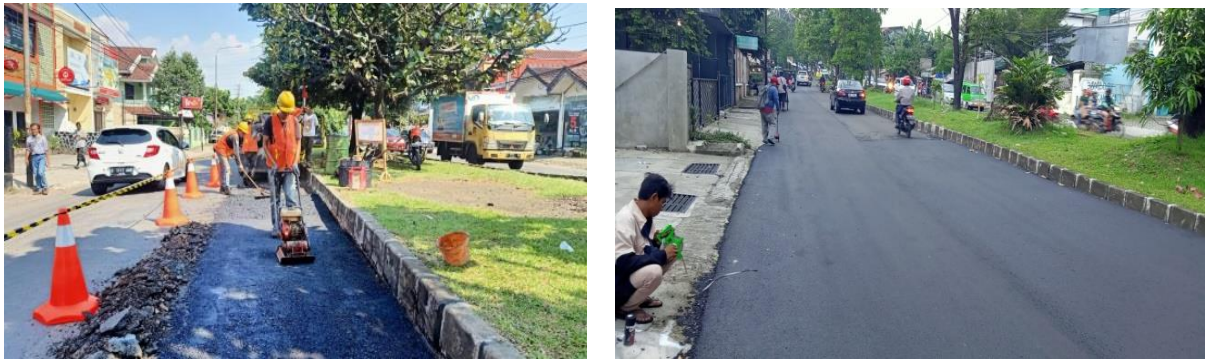
Gambar 2.3.53 Kegiatan Perbaikan Jalan
