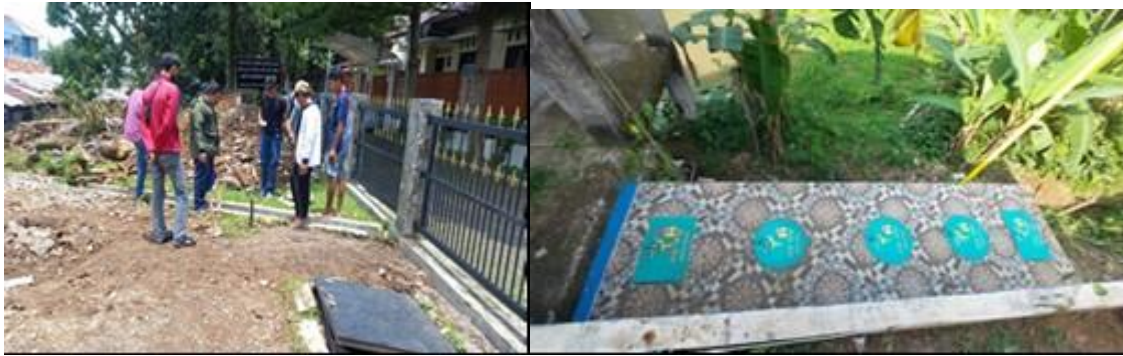
Gambar 2.3.12 Kegiatan Pembangunan SPALDT
